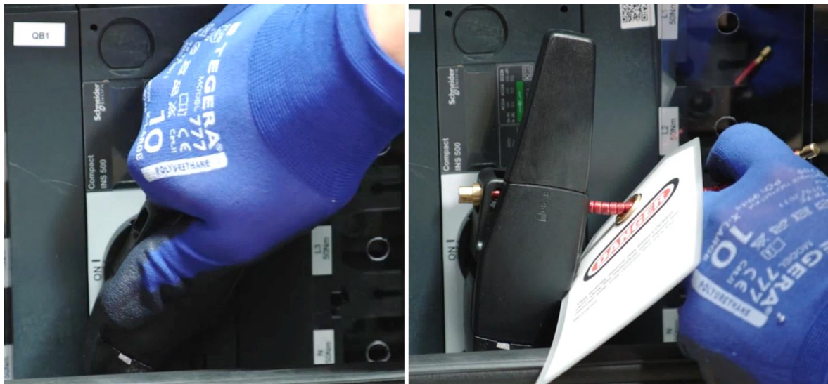
Abbildung 4: Hauptschalter ausschalten und sichern
