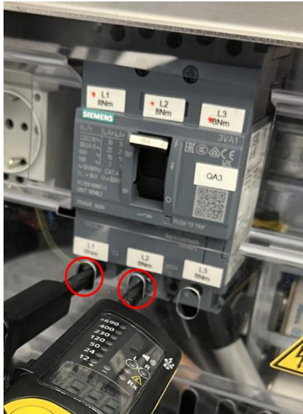
Abbildung 3: Spannungsmessung durchführen
