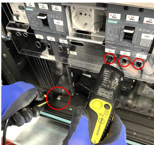
Abbildung 6: Messung der drei Phasen zum Potentialausgleich
