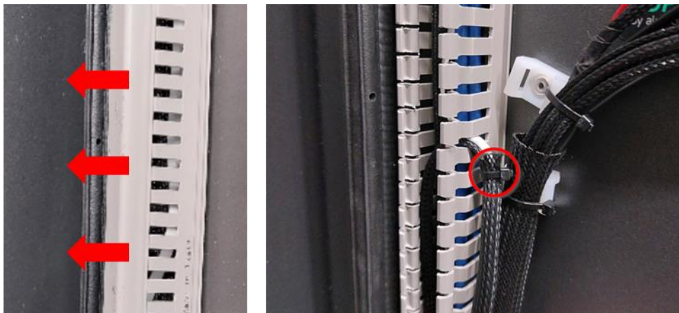
Abbildung 20: Abdeckung Kabelkanal entfernen und Kabel in Kabelkanal einfädeln
